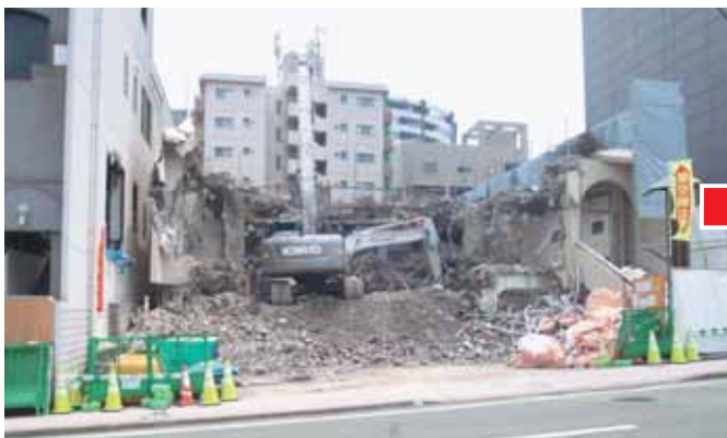
解体中の林業会館（8月1日撮影）
