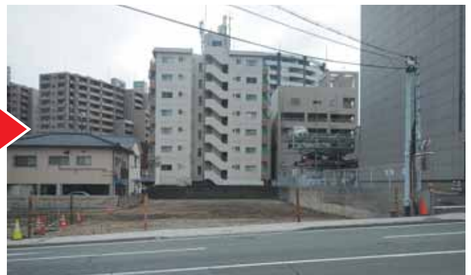
解体後の林業会館（9月19日撮影）
